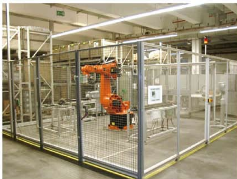
Roboterzelle mit zwei Förderstrecken Robot cell with two conveyor bands
